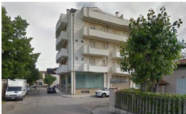
Foto 4 - Edificio sull'intersezione tra via Mazzola e Via Iseo
