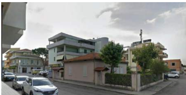
Foto 5 - Edificio sull'intersezione tra via Mazzola e Via Iseo
