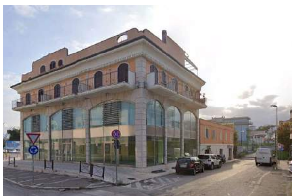
Foto 12 Edificio su via Nazionale intersezione Via Lago di Garda
