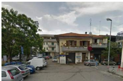
Foto 7 – Edificio al limite dell'ambito di intervento verso nord
