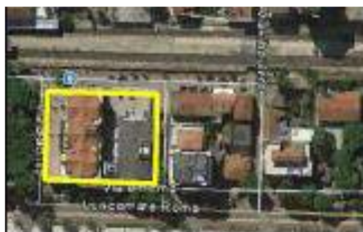
Figura 1 – Isolato tra Lungomare Celommi, via L'Aquila, via Cristoforo Colombo, via Grottaferrata
