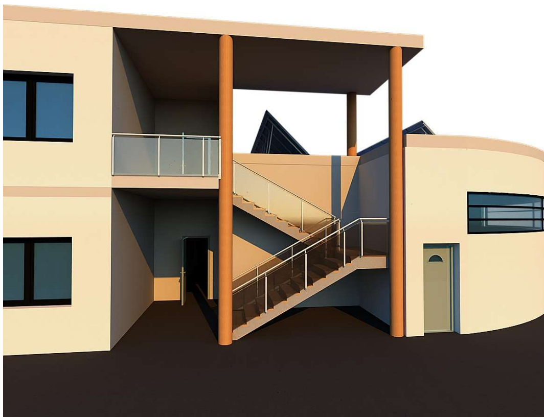
Nuovo padiglione particolare scala di emergenza
